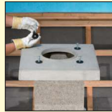
6.4 Наденьте плиту, под болтами установите гайки.
