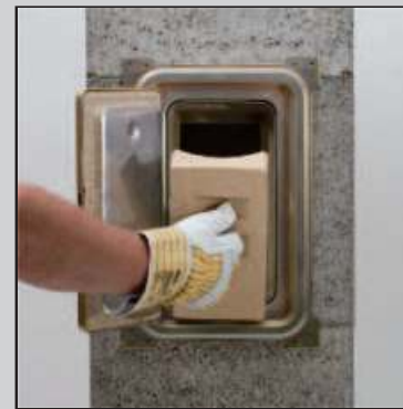
15.2 Вращающаяся внутренняя рама дверок прижмите к краям очистного тройника, чтобы не осталось отверстий.
