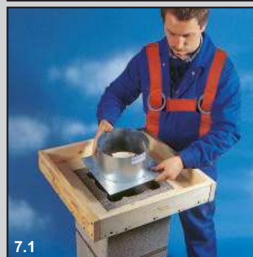
7.1 Установите опалубку необходимых размеров для бетонирования покровной плиты. Размер плиты должен быть не менее, чем на 5 см больше отделанного дымохода в целях защиты от осадков.
