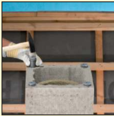
6.2 Прикрепите покровную плиту, вбивая штифты в верхний блок.
