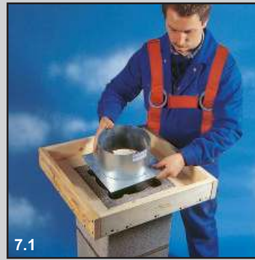
7.1 Установите опалубку необходимых размеров для бетонирования покровной плиты. Размер плиты должен быть не менее, чем на 5 см больше отделанного дымохода в целях защиты отдели от воздействия осадков.
