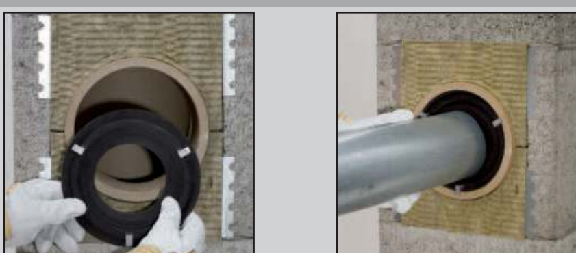
Обе части плиты из минваты обрежьте согласно отверстию, вырезанному в блоке. Прикрепите к плите металлич. крепления. Вставьте плиту в блок.
