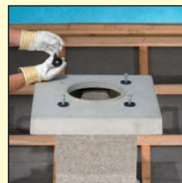
6.4 Наденьте плиту, под болтами установите гайки.
