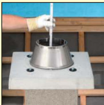
6.6 Наденьте конус и отмерьте недостающую длину трубы.
