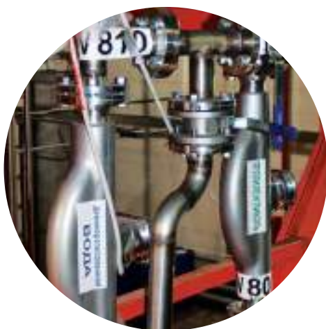
Кориолисовые расходомеры высокой точности (Endress+Hauser)
