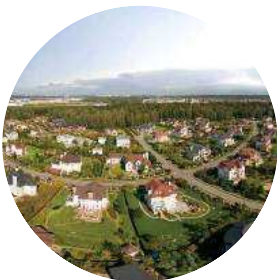
Коттеджный поселок «Павлово» Московская область
