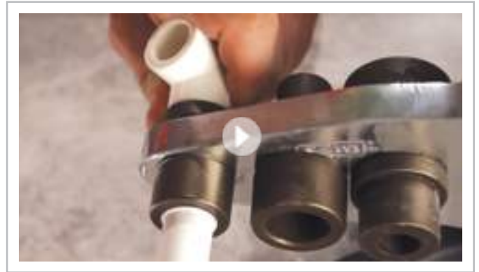
Монтаж полипропиленовых труб.
