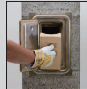
15.2 Вращающаяся внутренняя рама дверки прикрепите к краям очистного тройника, чтобы не осталось отверстий.
