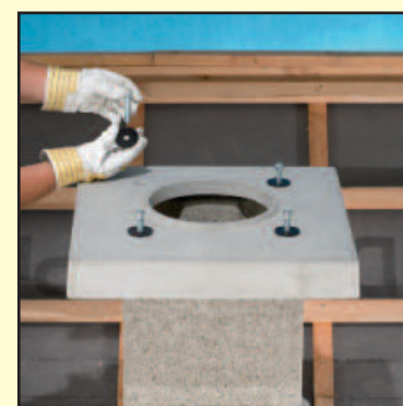
6.4 Наденьте плиту, под боками установите гайки.
