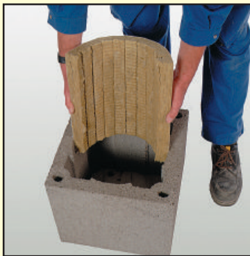
3.3 Согнутую минвату вложите внутрь блока и отрежьте так, чтобы вент. отверстия не были заблокированы!
