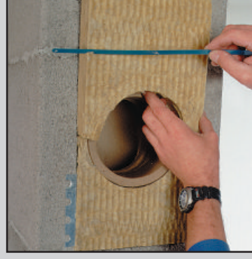
14.1 Обе части плиты из минваты обрежьте согласно отверстию, вырезанному в блоке.
