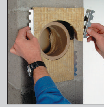
14.2 Прикрепите к плите металлические крепления. Вставьте плиту в блок.
