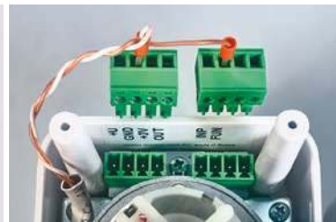
Фото 23. Подключение проводного выключателя
