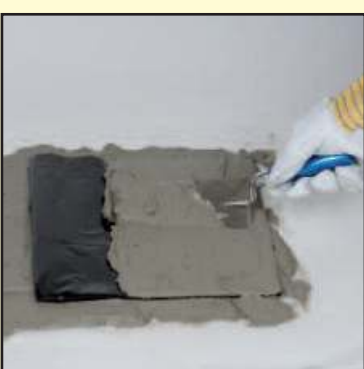
1.2 Подготовить раствор (марки не ниже M5), наложить гидроизоляцию, намажьте раствор.
