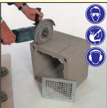
2.2 В нижней части блока вырежьте отмеченное отверстие, в него вставьте вент. решётку.
