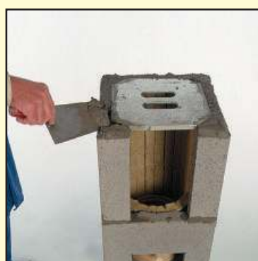
3.8 Блок с минватой установите на блок, используйте кладочную смесь.
