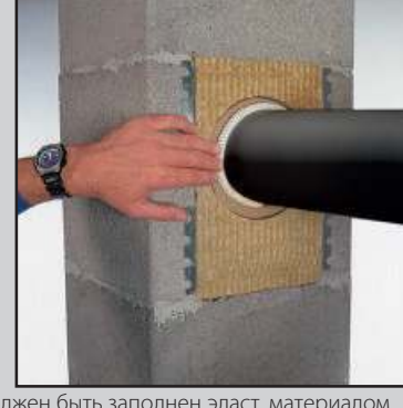
11.2 Подключение прибора на твёрдом топливе с адаптером.
