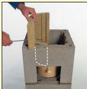
2.4 Вложите внутрь половину минваты, далее отрежьте ровно по краю блока. Оставшуюся часть ваты вложите в другую сторону и так же сравняйте с краем блока.
