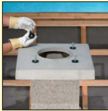
6.4 Наденьте плиту, под болтами установите гайки.
