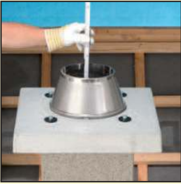
6.2 Наденьте конус и отмерьте недостающую длину трубы.
