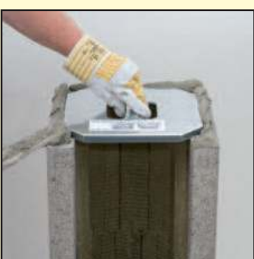
4.2 Нанесите смесь (не ниже марки M5), используя шаблон.
