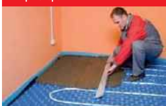
10. Заливка бетонной стяжки с пластификатором
