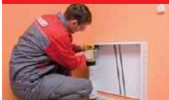
1. Монтаж коллекторного шкафа
