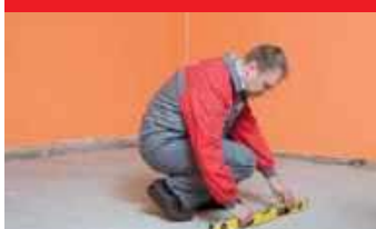
3. Подготовка поверхности пола
