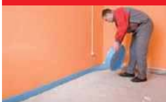
6. Укладка утеплителя (пенополистирол с покрытием)
