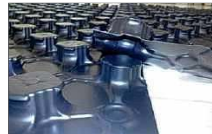
Рис. 33. Укладка плит внахлест с фиксацией края плит
