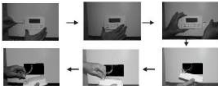
Рисунок 2. Порядок извлечения блока управления.
