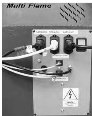
Rysunek 3 Moduł sterujący pracą palnika. (Przykładowy wygląd listwy w zależności od modelu sterownika zamontowanego na kotle)
