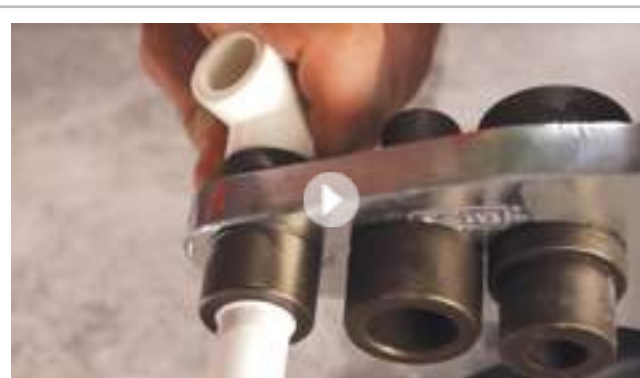
Монтаж полипропиленовых труб.
