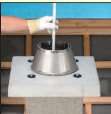
6.6 Наденьте конус и отмерьте недостающую длину трубы.
