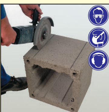
3.2 Угловой шлифовальной машиной вырежьте отверстие.
