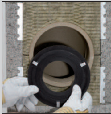
13.1 При подключении приборов на газовом и жидком топливе рекомендуется использовать прокладки «Schiedel».
