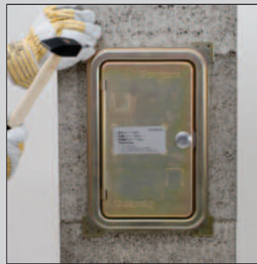
15.1 Прибейте дверцы гвоздями к блоку. Прикрепите дверцу, отштукатурьте дымоход слоем бетоно-известковой штукатурки.
