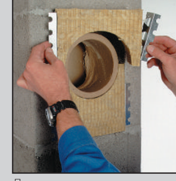
14.2 Прикрепите к плите металлические крепления. Вставьте плиту в блок.
