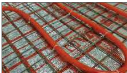
Рис. 2.7.2. Крепление труб стяжными хомутами к сетке
