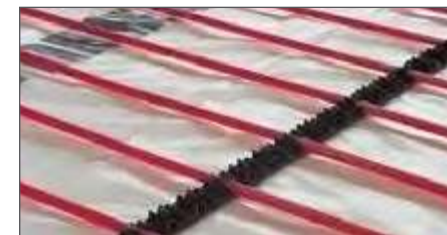
Рис. 2.7.6. Крепление труб тёплого пола с помощью шин-фиксаторов
