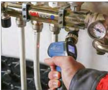
Рис. 4.1.5. Измерение температуры труб пирометром
