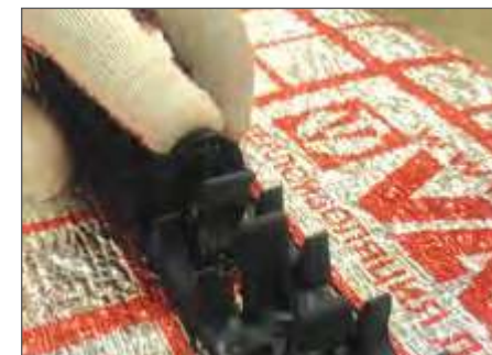
Рис. 2.7.7. Крепление шины гарпунной скобой к теплоизоляции
