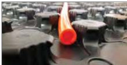
Рис. 2.7.1. Крепление труб между «бобышек» теплоизоляционных плит
