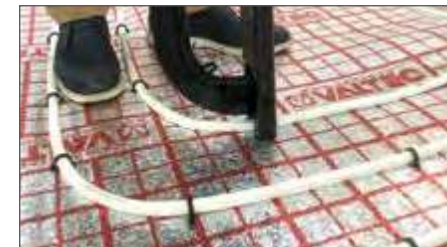
Рис. 2.7.5. Крепление труб скобами с помощью такера
