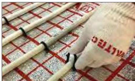
Рис. 2.7.4. Установка гарпунных скоб вручную
