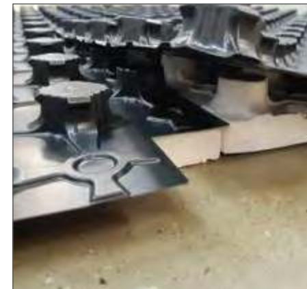
Рис. 2.6.1. «Замковое» соединение плит «Экопол 20»
