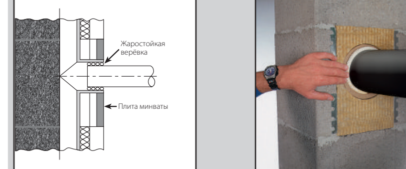
Необходимо оставить должный зазор. Этот зазор должен быть заполнен эластичным материалом (например жаростойкой ветошью).
