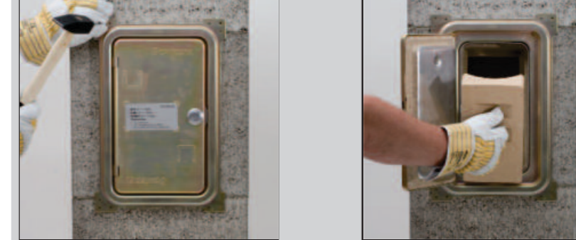
Прибейте дверцы гвоздиками к блоку. Прикрепив дверцу, отштукатурьте отверстие смесями бетоно-известковой штукатурки. Вращающую внутреннюю рамку дверцы прикрепите к краям очистного тройника, чтобы не оставалось отверстий.
