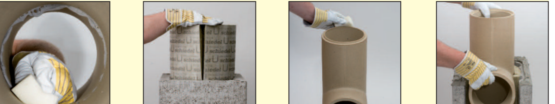
3.1 При помощи шаблона на стене блока отметьте нужный размер отверстия (шаблон у двери). 3.2 Угловой шлифовальной машиной вырежьте отверстие. 3.3 Согнутую минвату вложите внутрь блока и отрежьте так, чтобы вент. отверстия не были заблокированы! 3.4 При помощи шаблона нанесите смесь (шаблон в комплекте).
