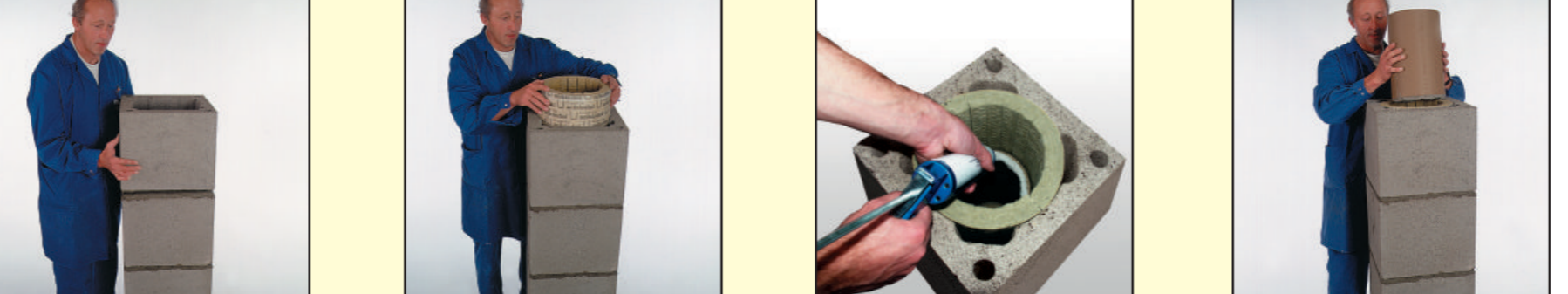
4.1 Положите шаблон на стену блока и отметьте необходимый размер. 4.2 Нанесите смесь (не ниже марки M5), используя шаблон. 4.3 Вент. каналы должны быть свободными! 4.4 Изолированный блок положите на готовый раствор (не ниже марки M5).
