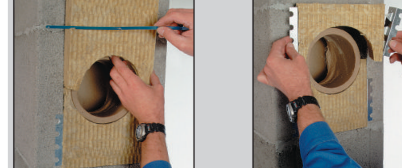
Обе части плиты из минваты обрежьте согласно отверстию, вырезанному в блоке. Прикрутите к плите металлические крепления. Вставьте плиту в блок.
