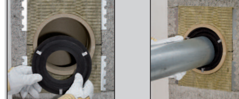
При подключении приборов на газом и жидком топливе рекомендуется использовать прокладку «Schiedel».
