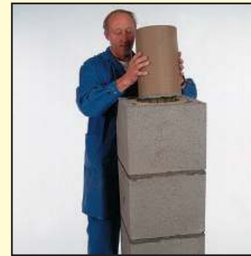
5.4 Вставьте керамическую трубу. Порядок сборки повторяется до завершения верхней части.
