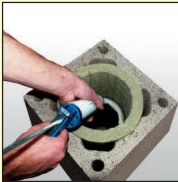
5.3 На край очищенной и увлажнённой трубы наложите жаростойкий герметик.
