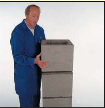
5.1 Поставьте блок на сборочную смесь.
