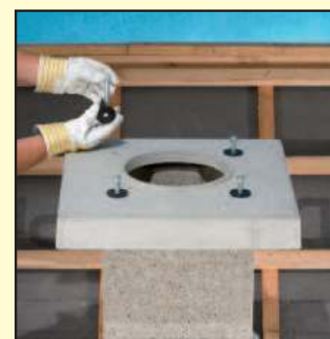
6.4 Наденьте плиту, под болтами установите гайки.
