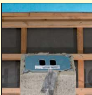
6.3 Нанесите раствор (не ниже марки М5), с использованием сборочного шаблона.
