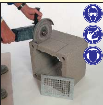
2.2 В нижней части блока вырежьте отмеченное отверстие, в него вставьте вент. решётку.
