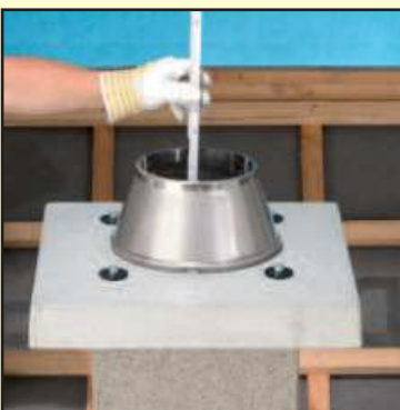
6.6 Наденьте конус и отмерьте недостающую длину трубы.
