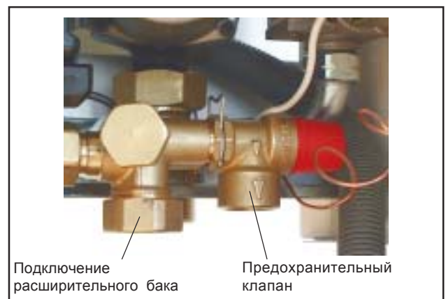
Рис.: Предохранительный клапан, подключение расширительного бака
