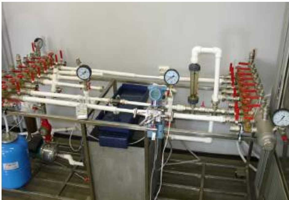
Рис.2.4.3.р.8 Стенд гидравлических испытаний
