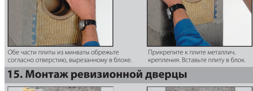
Обе части плиты из минваты обрежьте согласно отверстию, вырезанному в блоке. Прикрутите к плите металлические крепления. Вставьте плиту в блок.
