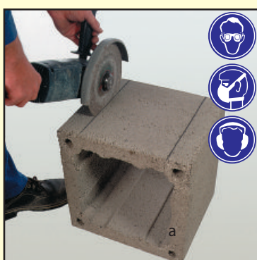
3.2 Угловой шлифовальной машиной вырежьте отверстие.
