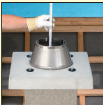
6.2 Наденьте конус и отмерьте недостающую длину трубы.
