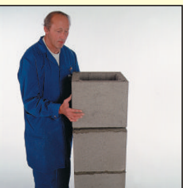
5.1 Поставьте блок на сборочную смесь.
