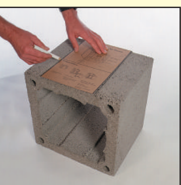
2.1 При помощи шаблона на стенке блока отметьте нижний размер отверстия (шаблон у дверок).
