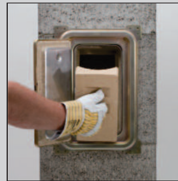
15.2 Вращающаяся внутренняя рама дверки прикрепите к краям очистного тройника, чтобы не осталось отверстий.
