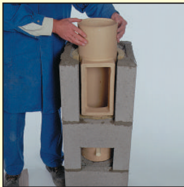
3.2 Угловой шлифовальной машиной вырежьте отверстие.
