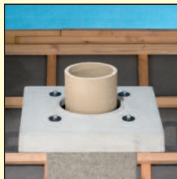
6.3 Отрежьте недостающую часть шамотной трубы и прикрепите клеем.
