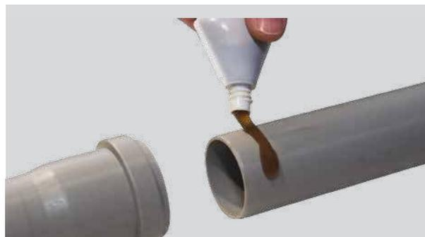
При вставке трубы на уплотнительном кольце не должно быть смазки. Выровняйте по центру вставляемый конец трубы и до упора задвиньте в раструб.
