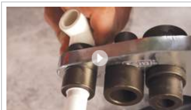
Монтаж полипропиленовых труб.
