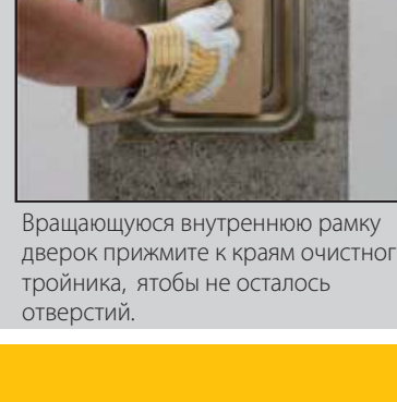
15.2 Вращающаяся внутренняя рама дверок прижимается к краям очистного тройника, чтобы не осталось отверстий.
