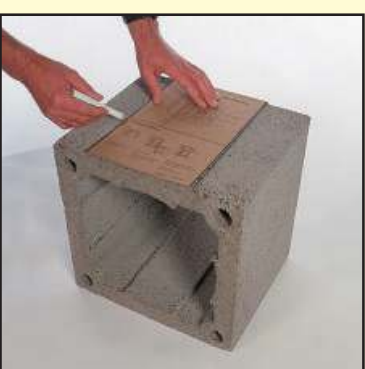
2.1 При помощи шаблона на стенке блока отметьте нужный размер отверстия (шаблон у дверок).
