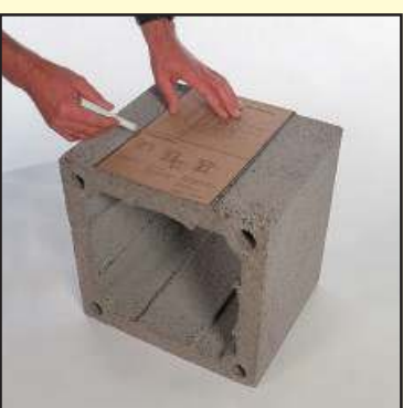
3.5 На очищенный край сборки конденсата нанесите герметик.
