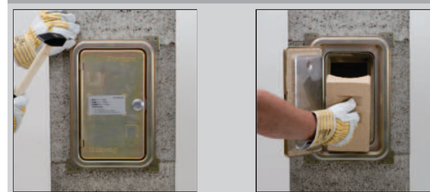
Прибейте дверцы гвоздями к блоку. Прикрыв дверцу, отштукатурьте отверстие с помощью смеси бетона-известковой штукатурки. Вращающую внутреннюю раму дверок прижмите к краям очистного тройника, чтобы не осталось отверстий.
