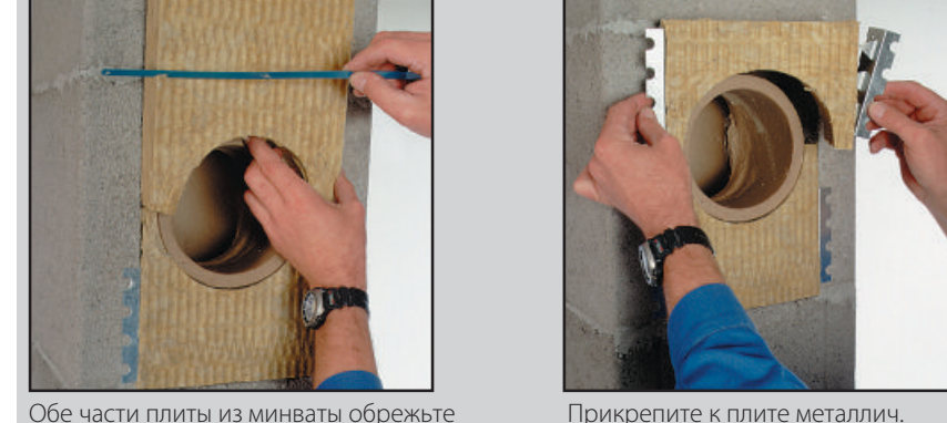
Обе части плиты из минваты обрежьте согласно отверстию, вырезанному в блоке. Прикрутите к плите металлические крепления. Вставьте плиту в блок.
