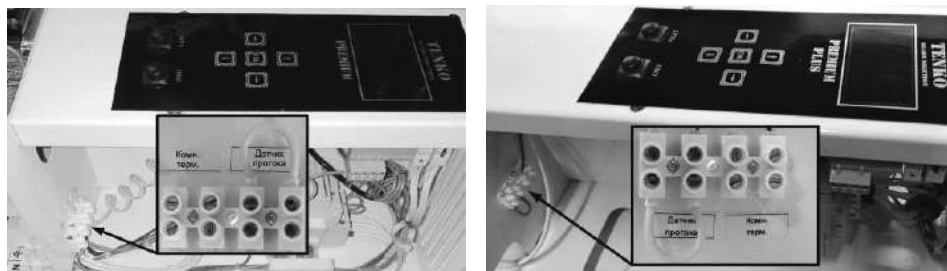
Рисунок 14.2 – Расположение клеммы подключения внешнего (комнатного) термостата: а – в котлах «Премиум»; б – в котлах «Премиум Плюс»
