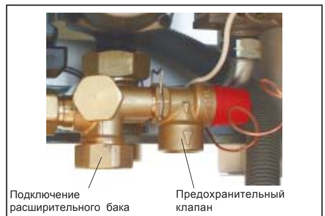
Рис.: Предохранительный клапан, подключение расширительного бака
