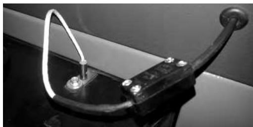
Rysunek 4 Czujnik temperatury spalin zamontowany w czopuchu
