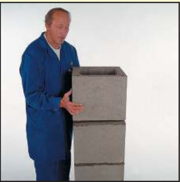
5.1 Поставьте блок на сборочную смесь.
