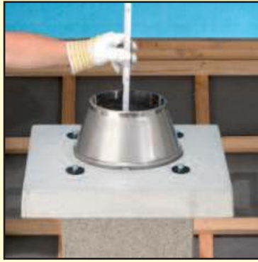
6.6 Наденьте конус и отмерьте недостающую длину трубы.
