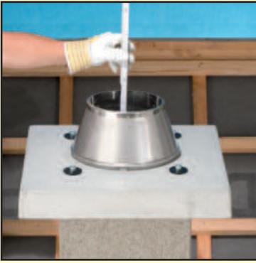
6.6 Наденьте конус и отмерьте недостающую длину трубы.
