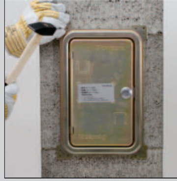
15.1 Прибейте дверцы гвоздями к блоку. Прикрепите дверцу, отштукатурьте дымоход слоем бетоно-известковой штукатурки.
