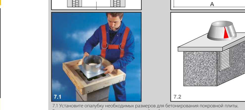
7.1 Установите опалубку необходимых размеров для формирования покровной плиты. Размер плиты должен быть не менее, чем на 5 см больше отдаленного диаметра в целях защиты отдели от воздействия осадков.
