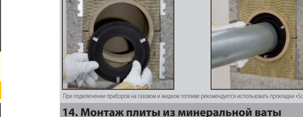
При подключении приборов на газовом и жидком топливе рекомендуется использовать прокладки «Schiedel».
