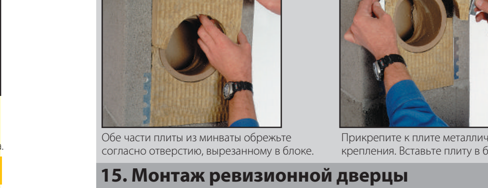
Обе части плиты из минваты обрежьте согласно отверстию, вырезанному в блоке.
