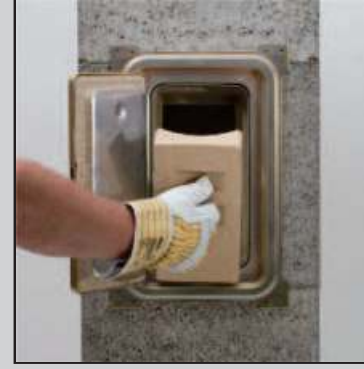
15.2 Вращающаяся внутреннюю раму дверок прижмите к краям очистного тройника, чтобы не осталось отверстий.
