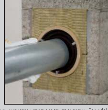
13.2 Подключение приборов на газовом и жидком топливе.
