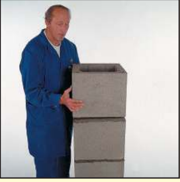
5.1 Поставьте блок на сборочную смесь.
