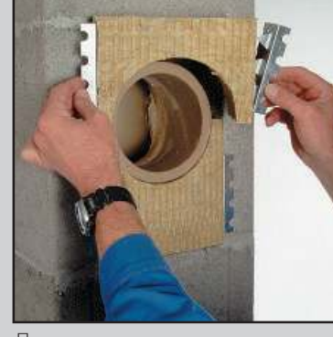
14.2 Прикрепите к плите металл. крепления. Вставьте плиту в блок.
