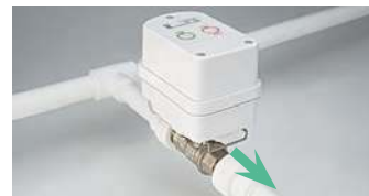
Фото 9. Удаление металлического фиксатора
