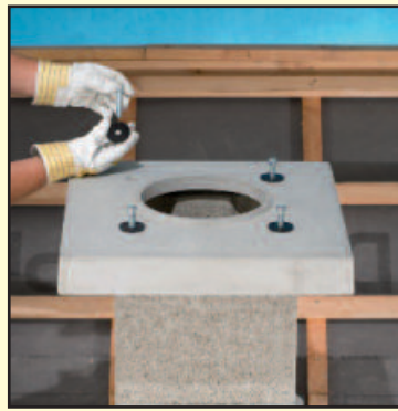
6.4 Наденьте плиту, под богами установите гайки.
