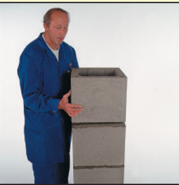
5.1 Поставьте блок на сборочную смесь.
