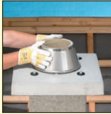
6.4 Наденьте конус. Важно не повредить опорные части конуса, которые создают оптимальное расстояние между конусом и покровной плитой для вентиляции дымохода.
