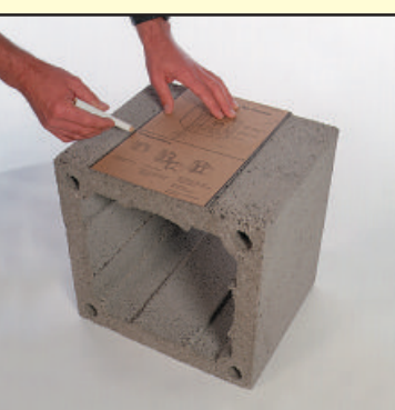
3.5 На очищенный край сборки конденсата нанесите герметик.
