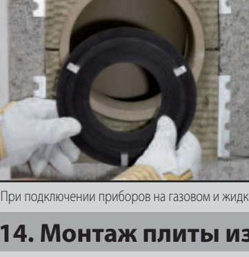
13.1 Подключение приборов на газовом и жидком топливе.
