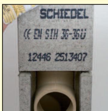
4.4 Изолированный блок положите на готовый раствор (не ниже марки М5).
