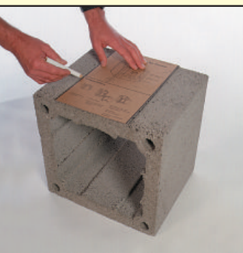
2.1 При помощи шаблона на стене блока отметьте нужный размер отверстия (шаблон у дверок).
