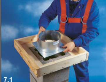
7.1 Установите опалубку необходимых размеров для бетонирования покровной плиты. Размер плиты должен быть не менее, чем на 5 см больше отделанного дымохода в целях защиты от осадков.
