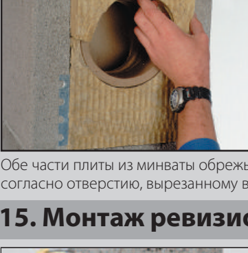
14.1 Монтаж плиты из минеральной ваты.
