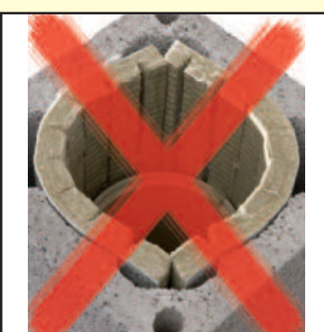
4.3 Вент. каналы должны быть свободными!
