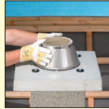
6.4 Наденьте конус. Важно не повредить опорные части конуса, которые создают оптимальное расстояние между конусом и покровной плитой для вентиляции дымохода.
