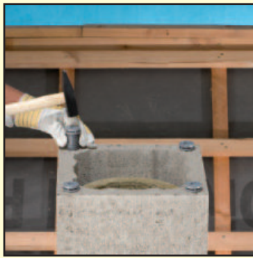
6.2 Прикрутите покровную плиту, вбивая штифты в верхний блок.
