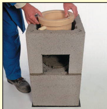
2.3 Установите блок на цоколь со смесью. Внутри блока вложите сборник конденсата. Сборник положите на смесь, стеновую трубу направьте в сторону отверстия.
