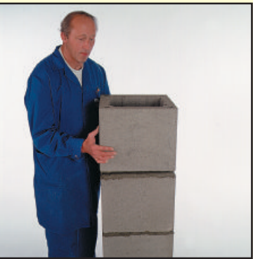
5.1 Поставьте блок на сборочную смесь.
