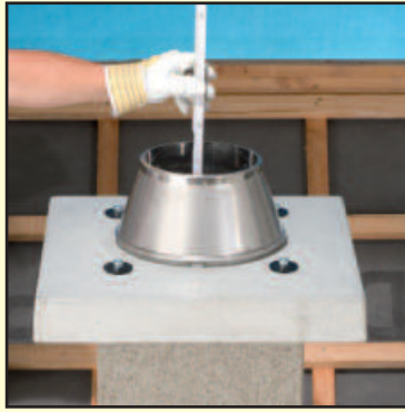
6.2 Наденьте конус и отмерьте недостающую длину трубы.
