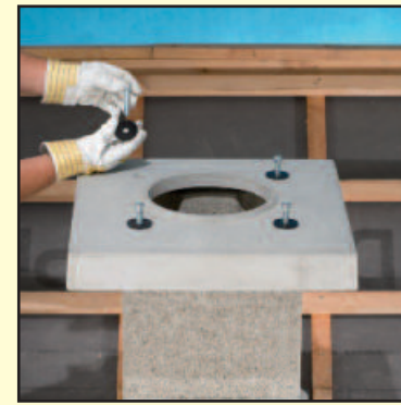
6.4 Наденьте плиту, под болтами установите гайки.
