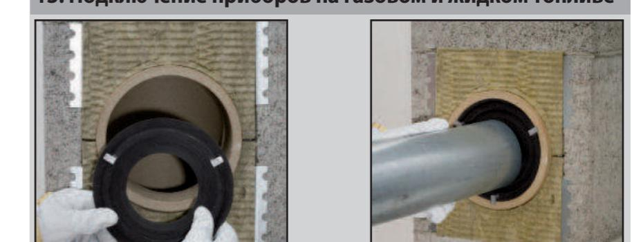
При подключении приборов на газовом и жидкое топливо рекомендуется использовать прокладки «Schiedel».
