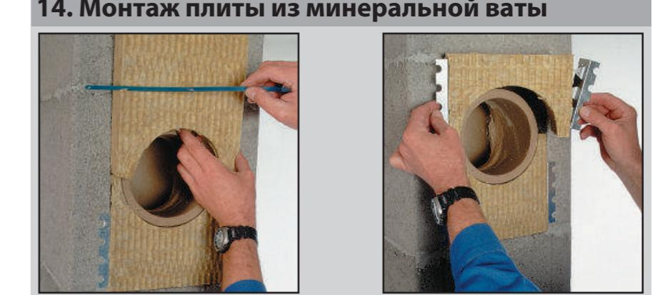
Обе части плиты из минваты обрезьте согласно отверстию, вырезанному в блоке.
