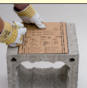
4.1 Положите шаблон на стену блока и отметьте необходимый размер.
