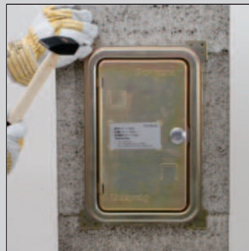
15.1 Прибейте дверцы гвоздями к блоку. Прикрепив дверцу, отштукатурьте дымоход слоем бетоно-известковой штукатурки.
