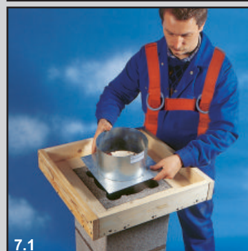
7.1 Установите опалубку необходимых размеров для бетонирования покровной плиты. Размер плиты должен быть не менее, чем на 5 см больше отделанного дымохода в целях защиты от влаги от воздействия осадков.
