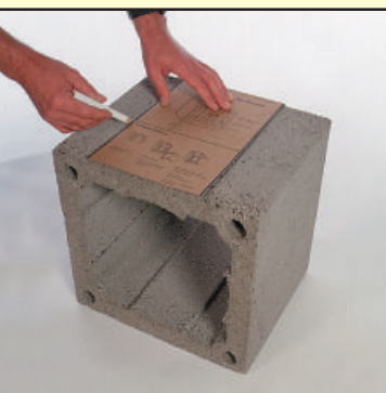
2.1 При помощи шаблона на стене блока отметьте нужный размер отверстия (шаблон у дверок).
