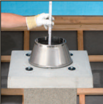
6.6 Наденьте конус и отмерьте недостающую длину трубы.
