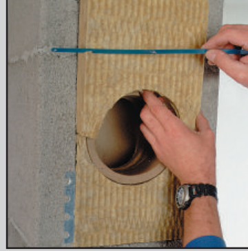
14.1 Обе части плиты из минваты обрежьте согласно отверстию, вырезанному в блоке.
