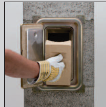
15.2 Вращающаяся внутренняя рама дверок прикрепите к краям очистного тройника, чтобы не осталось отверстий.
