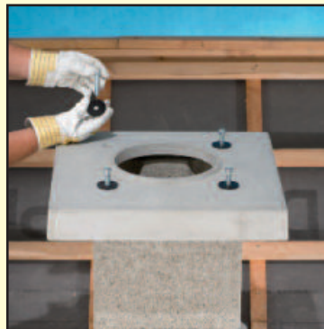
6.4 Наденьте плиту, под богами установите гайки.
