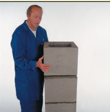
5.1 Поставьте блок на сборочную смесь.
