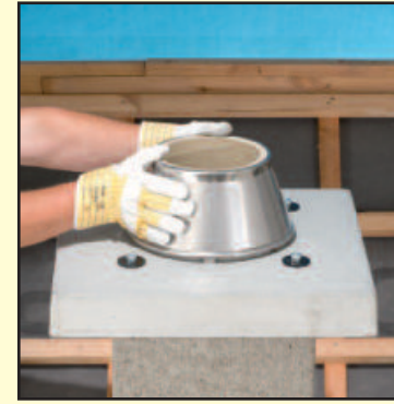
6.8 Наденьте конус. Важно не повредить опорные части конуса, которые создают оптимальное расстояние между конусом и покровной плитой для вентиляции дымохода.
