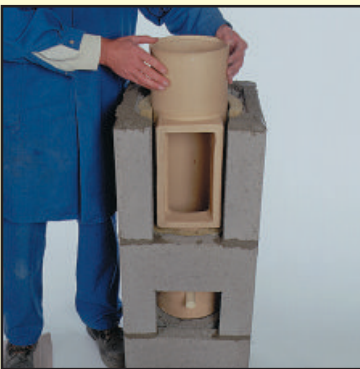
3.2 Угловой шлифовальной машиной вырежьте отверстие.
