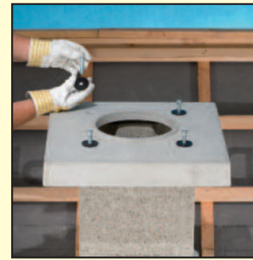
6.4 Наденьте плиту, под боками установите гайки.
