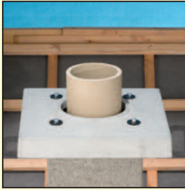
6.7 Отрежьте недостающую часть шамотной трубы и прикрепите клеем.
