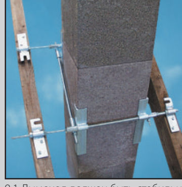
9.1 Дымоход должен быть стабильно закреплен между стропилами, используя крепления «Schiedel» (инструкция сборки приложена к креплениям).
