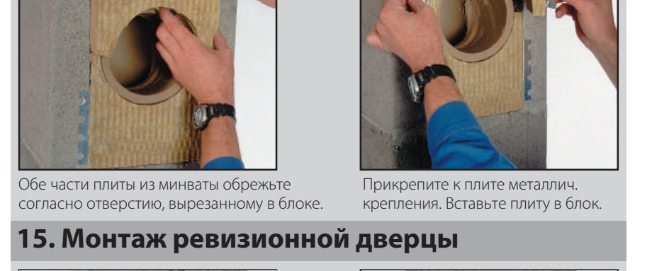
Обе части плиты из минваты обрежьте согласно отверстию, вырезанному в блоке. Прикрепите к плите металлические крепления. Вставьте плиту в блок.
