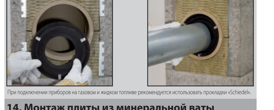
При подключении приборов на газовом и жидком топливе рекомендуется использовать прокладки «Schiedel».
