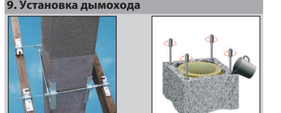
9.1 Дымоход должен быть стабильно закреплен между стропилами, используя крепления «Schiedel» (инструкция сборки приложена к креплениям). 9.2 Если дымоход поднимается выше кровельного покрытия более, чем на 1,2 метра, он должен быть армирован. Рекомендуем использовать армирующий комплект «Schiedel» (инструкция сборки приложена к арм. элементам).
