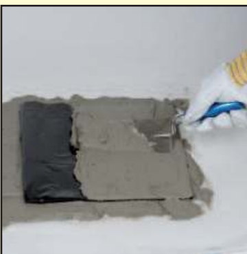
1.2 Подготовить раствор (марки не ниже M5), наложить гидроизоляцию, намажьте раствор.
