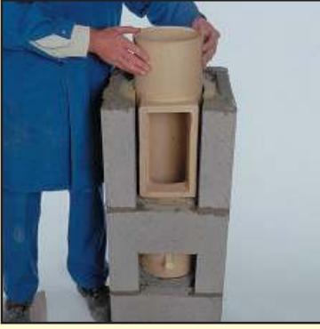
3.2 Угловой шлифовальной машиной вырежьте отверстие.
