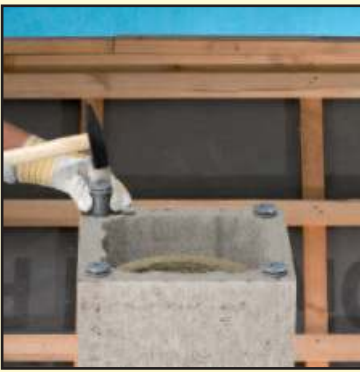
6.2 Прикрепите покровную плиту, вбивая штифты в верхний блок.
