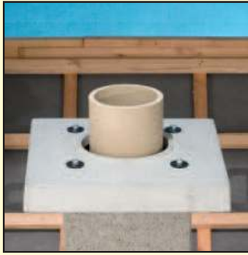
6.3 Отрежьте недостающую часть шамотной трубы и прикрепите клеем.
