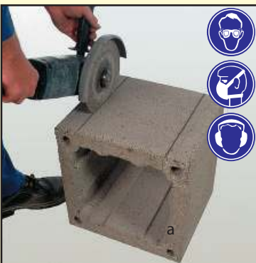
3.2 Угловой шлифовальной машиной вырежьте отверстие.
