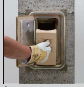
15.2 Вращающаяся внутренняя рама дверок прижмите к краям очистного тройника, чтобы не осталось отверстий.
