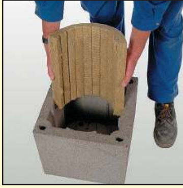
3.3 Согнутую минвату вложите внутрь блока и отрежьте так, чтобы вент. отверстия не были заблокированы.
