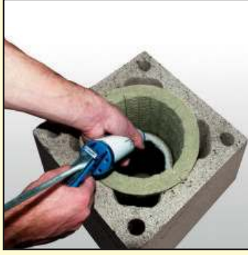
5.3 На край очищенной и увлажненной трубы наложите жаростойкий герметик.
