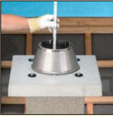
6.2 Наденьте конус и отмерьте недостающую длину трубы.
