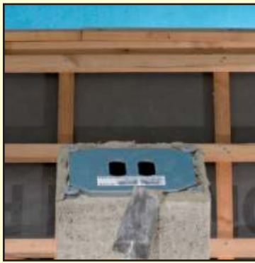
6.3 Нанесите раствор (не ниже марки M5), с использованием сборочного шаблона.
