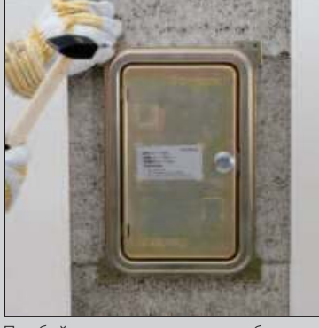
15.1 Прибейте дверки гвоздями к блоку. Прикрепив дверцу, отштукатурьте дымоход слоем бетоно-известковой штукатурки.
