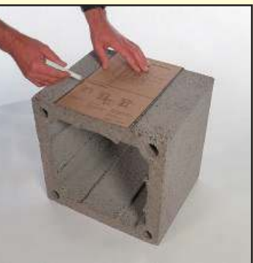
3.1 При помощи шаблона на стенке блока отметьте нужный размер отверстия (шаблон у дверок).
