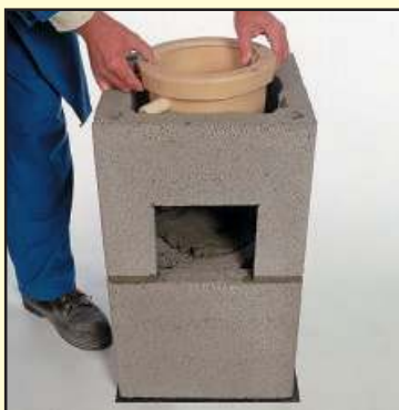
2.3 Установите блок на цоколь со смесью. Внутри блока вложите сборник конденсата. Сборник положите на смесь, стеновую трубу направьте в сторону отверстия.
