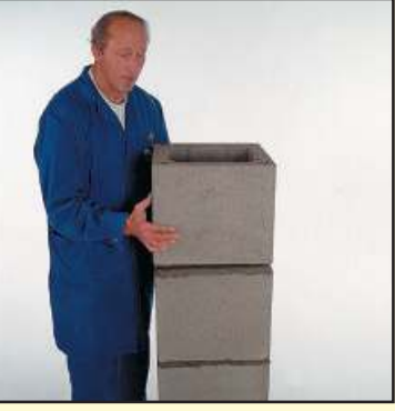
5.1 Поставьте блок на сборочную смесь.
