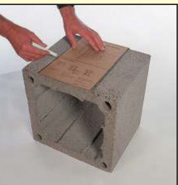
2.1 При помощи шаблона на стенке блока отметьте нужный размер отверстия (шаблон у дверок).
