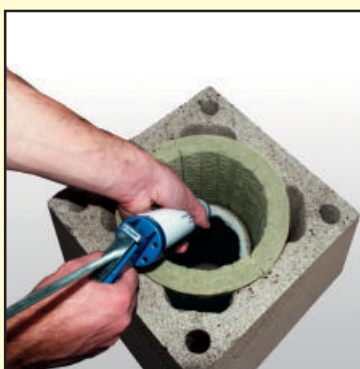
5.3 На край очищенной и увлажненной трубы наложите жаростойкий герметик.
