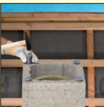
6.2 Прикрутите покровную плиту, вбивая штифты в верхний блок.
