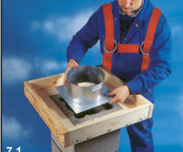
7.1 Установите опалубку необходимых размеров для бетонирования покровной плиты. Размер плиты должен быть не менее, чем на 5 см больше отделанного дымохода в целях защиты от воздействия осадков.
