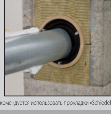
14. Монтаж плиты из минеральной ваты
