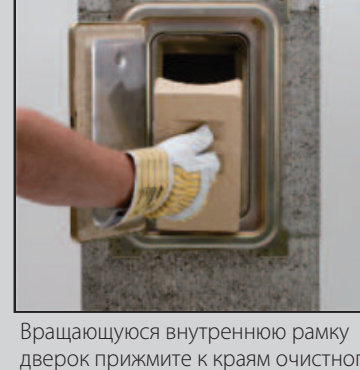
Вращающаяся внутренняя рама дверок прижмите к краям очистного тройника, чтобы не осталось отверстий.
