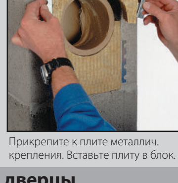
15. Монтаж ревизионной дверцы
