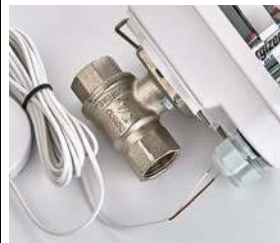
Фото 8. Завести провод датчика в кабельный ввод
