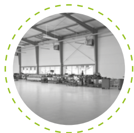
Воздушное отопление и вентиляция
