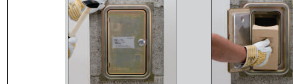
Обе части плиты из минваты обрежьте согласно отверстию, вырезанному в блоке. Прикрутите к плите металлические крепления. Вставьте плиту в блок.
