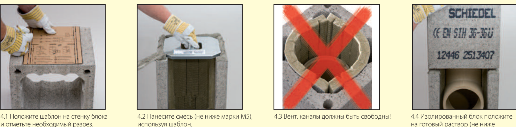
4.1 Положите шаблон на стену блока и отметьте необходимый размер. 4.2 Нанесите смесь (не ниже марки М5), используя шаблон. 4.3 Вент. каналы должны быть свободными! 4.4 Изолированный блок положите на готовый раствор (не ниже марки М5).
