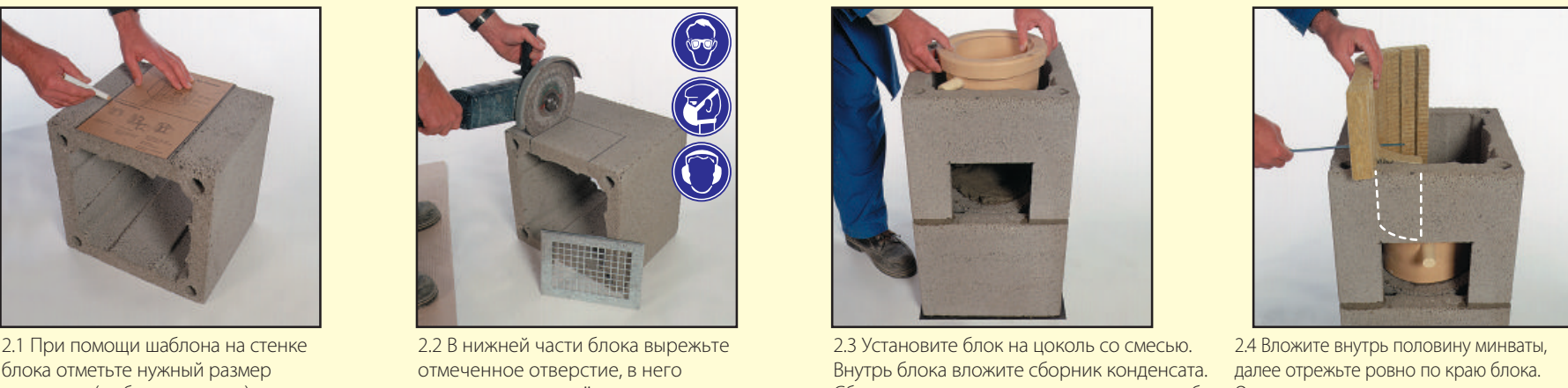
2.1 При помощи шаблона на стене блока отметьте нужный размер отверстия (шаблон у двери). 2.2 В нижней части блока вырежьте отмеченное отверстие, в него вставьте вент. решётку. 2.3 Установите блок на цоколь со смесью. Внутрь блока вложите сборник конденсата. Сборник положите на смесь, стеновую трубу направьте в сторону отверстия. 2.4 Вложите внутрь половину минваты, далее отрежьте ровно по краю блока. Оставшуюся часть ваты вложите в другую сторону и так же срежьте с краем блока.
