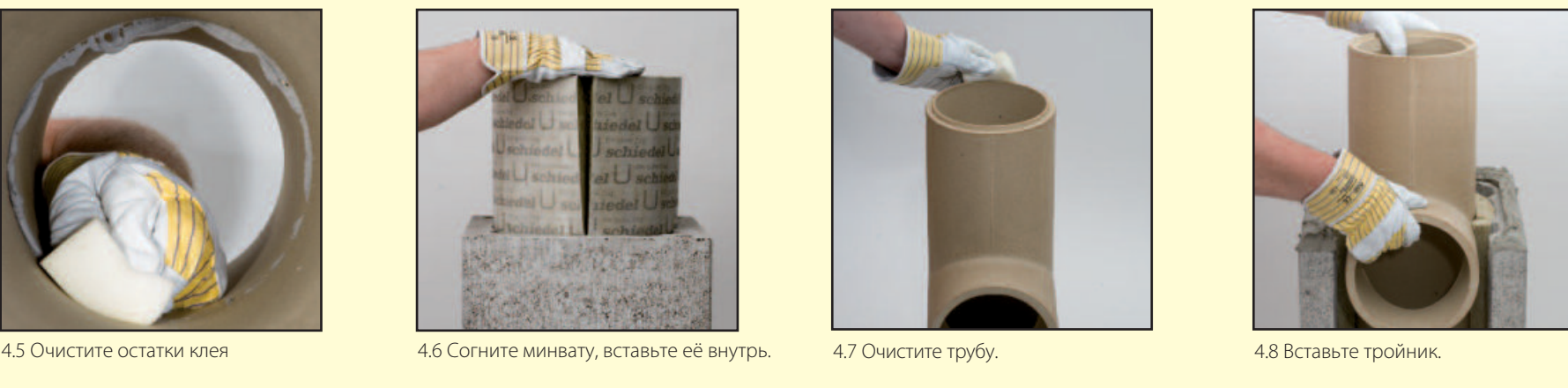
4.5 Очистите остатки клея. 4.6 Согните минвату, вставьте её внутрь. 4.7 Очистите трубу. 4.8 Вставьте тройник.
